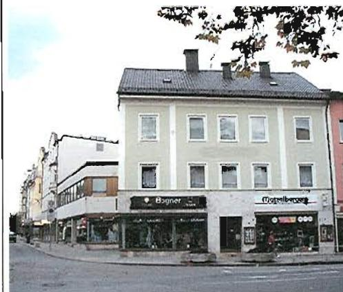
Lastabtragung des Mauerwerks ins „Nichts“: Der Eindruck der Gebäudestatik stimmt nicht mehr.
