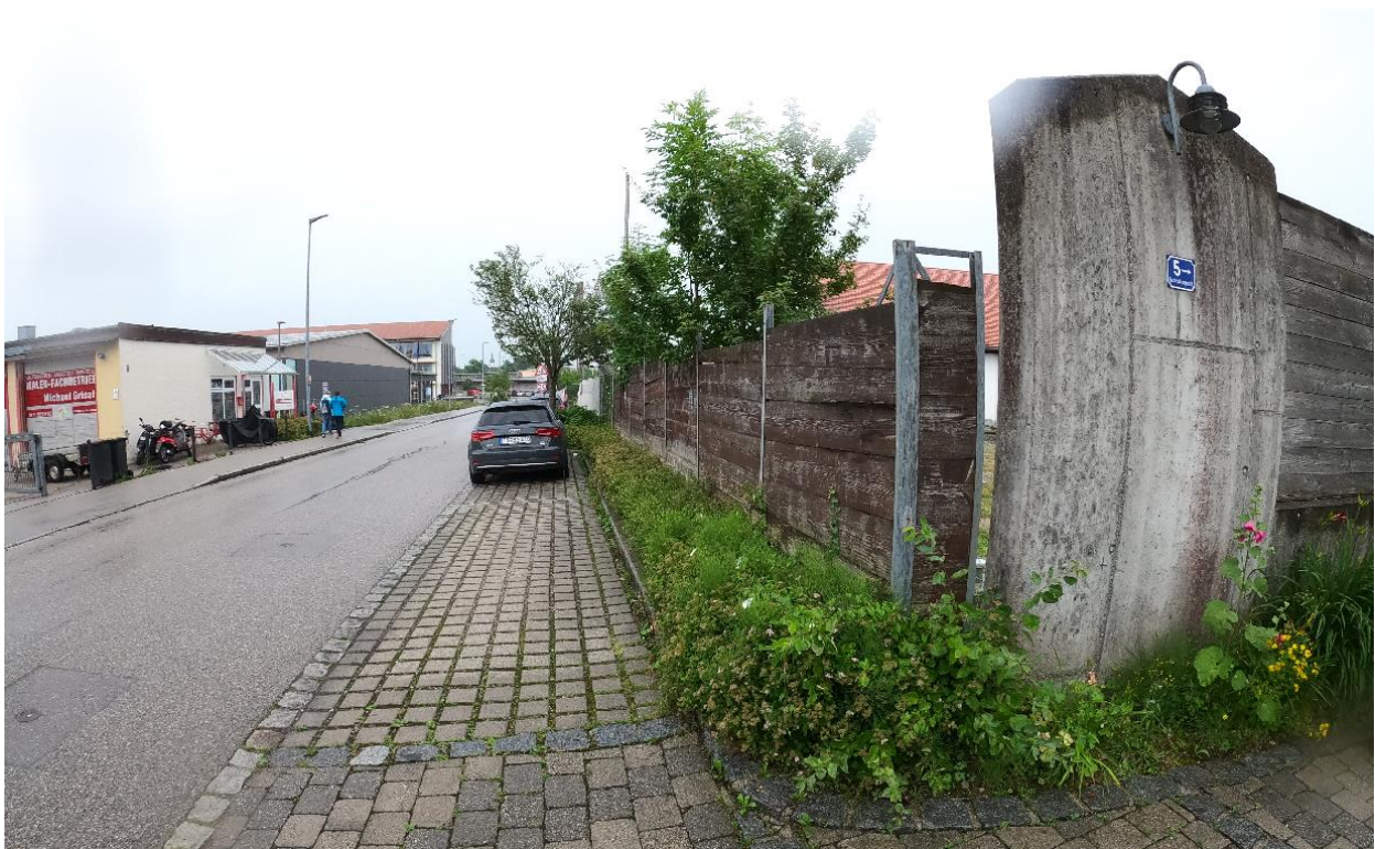
Abbildung 6.4: Mauer entlang der westlichen Grundstücksgrenze, Gabelsbergerstraße (Ortseinsicht cfLab GmbH, Juni 2022)
