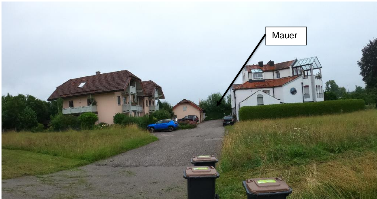
Abbildung 6.2: Mauer Anwesen Anton-Beilhack-Straße 7 (Ortseinsicht cfLab GmbH, Juni 2022)
