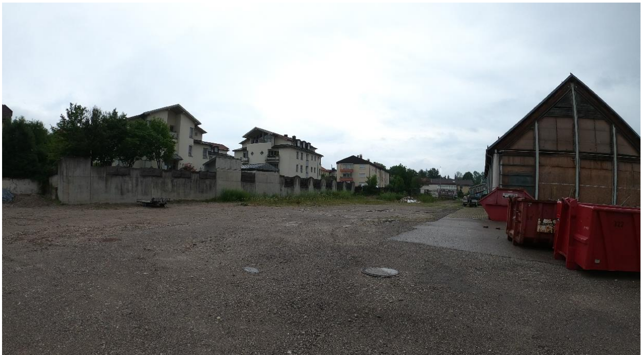
Abbildung 6.3: Mauer entlang der westlichen Grundstücksgrenze (Ortseinsicht cfLab GmbH, Juni 2022)
